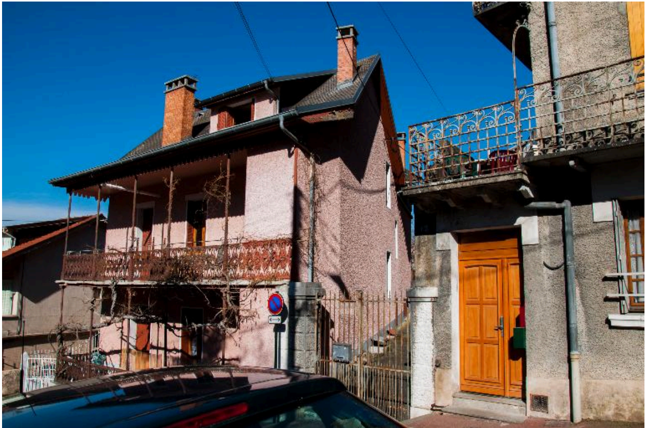
Les Glycines, 11 rue du bain Henri IV (parcelle BZ 132) : vue de trois-quart depuis le sud-est
