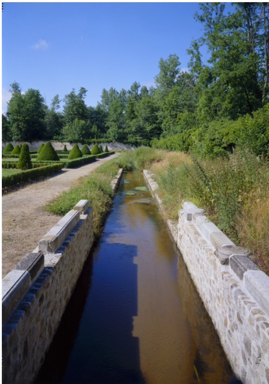
Vue du canal longeant le parterre de carrés en cours de réaménagement, du sud-est (bases de colonnes en place sur le muret ouest).
