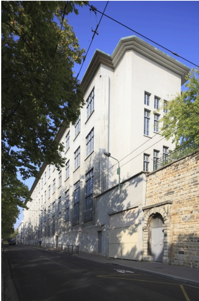
Elévation cours Général Giraud. Accès à l'escalier en redoute conduisant à la maison du directeur.
