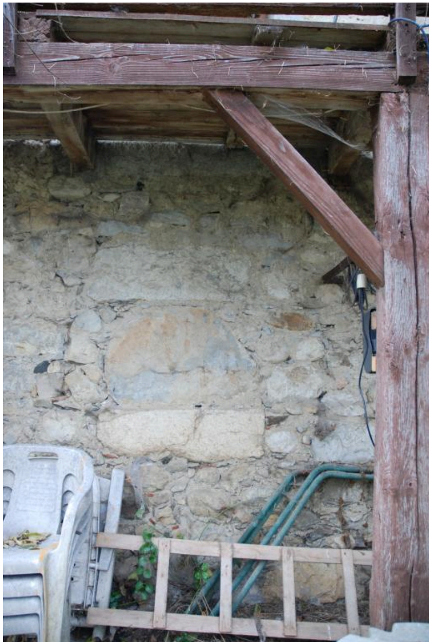
Maison, élévation sud : bouche de four à pain murée (?).
