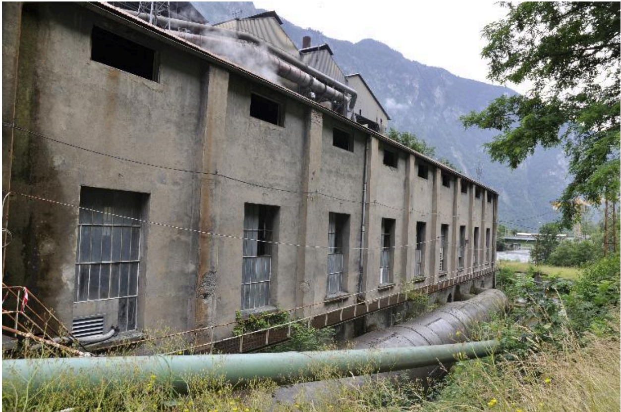
Vue de la façade arrière de Pierre-Eybesse II et des conduites forcées
