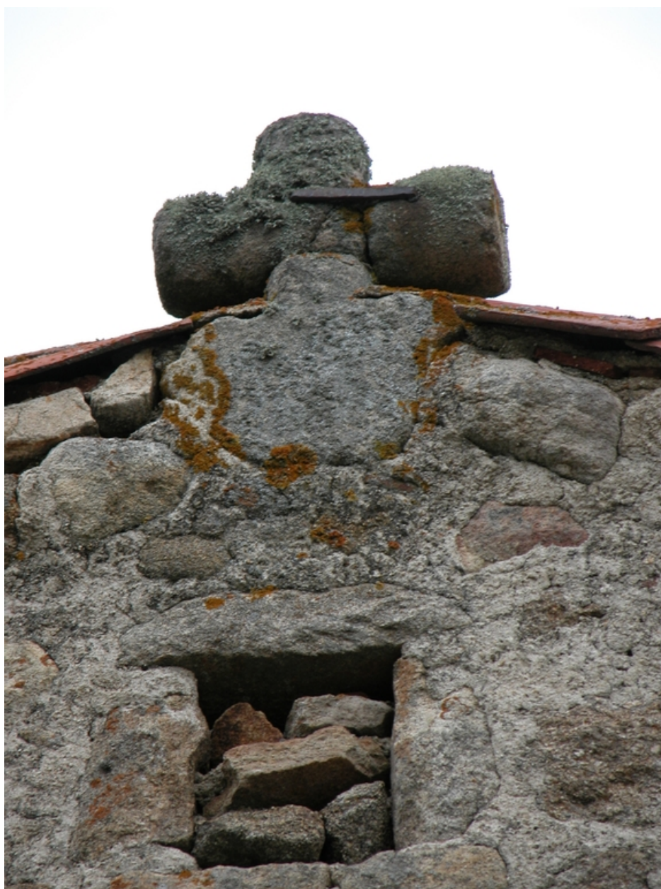
Détail de la croix sur le pignon du bâtiment sud-ouest.
