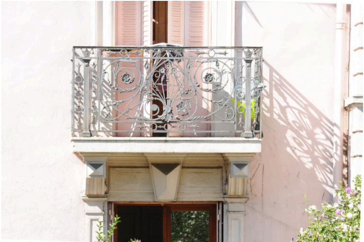
Détail sur le balcon et le garde-corps au 1er étage de l'aile ouest
