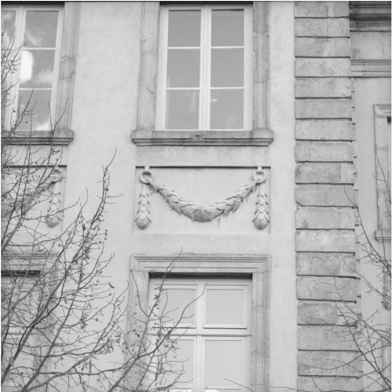
Détail de la façade sur jardin : guirlande de laurier.
