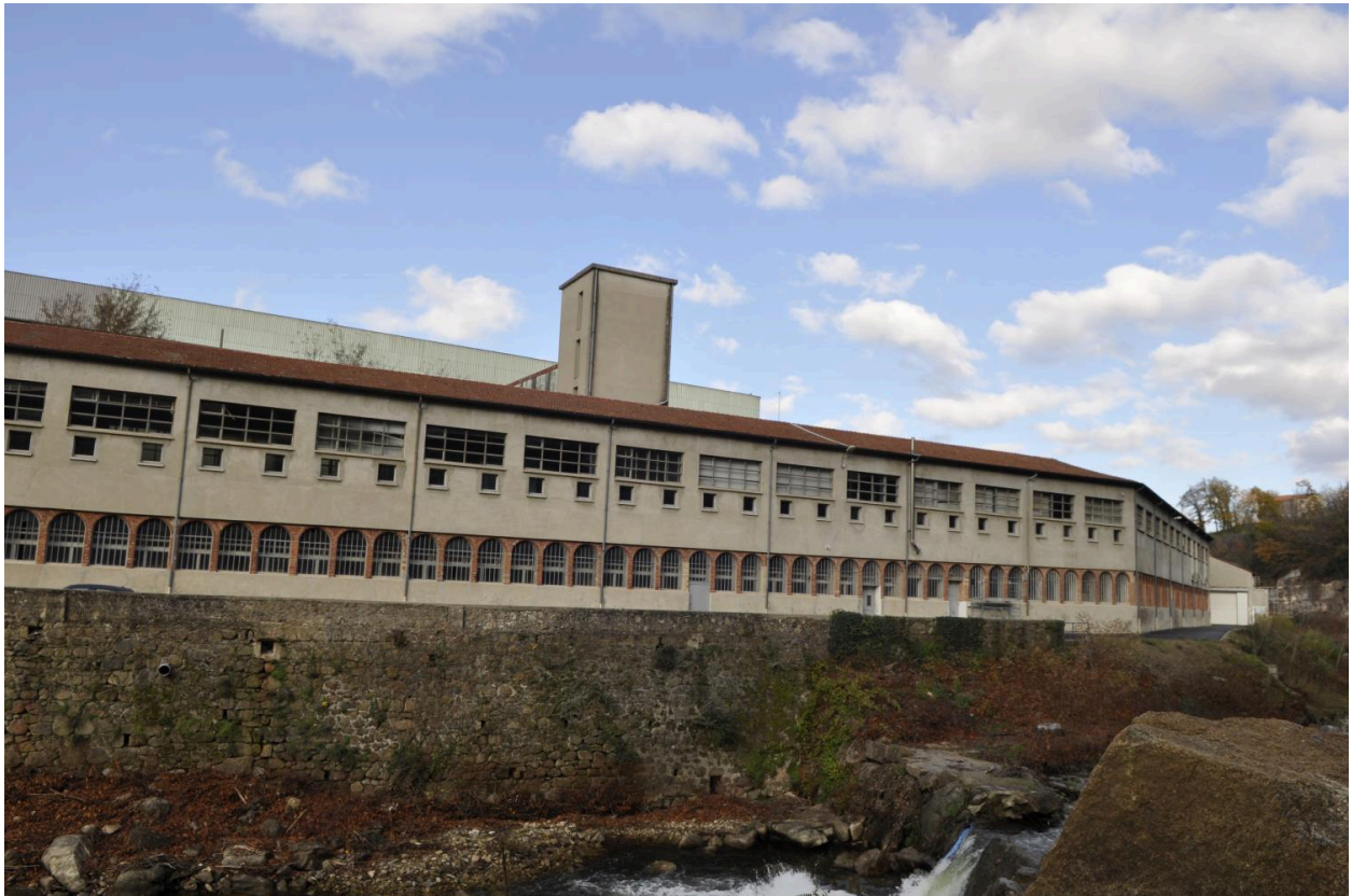
Façade du bâtiment de la machine à papier
