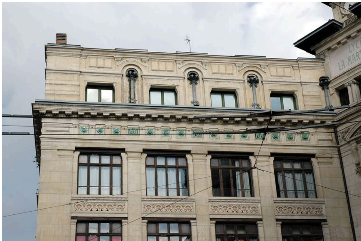
Détail de l'élévation antérieure
