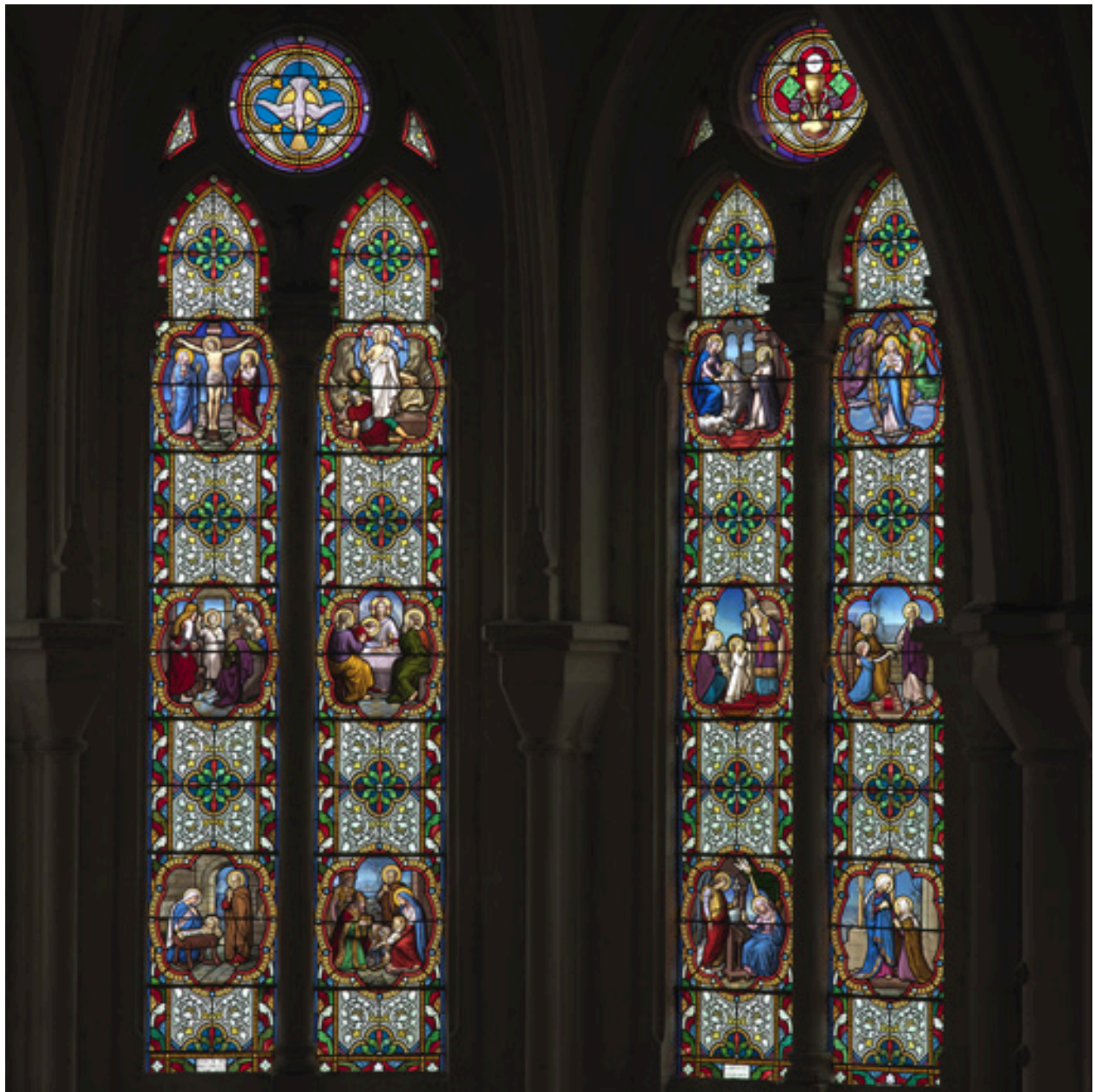
Vue d'ensemble des baies 0 et 2.
