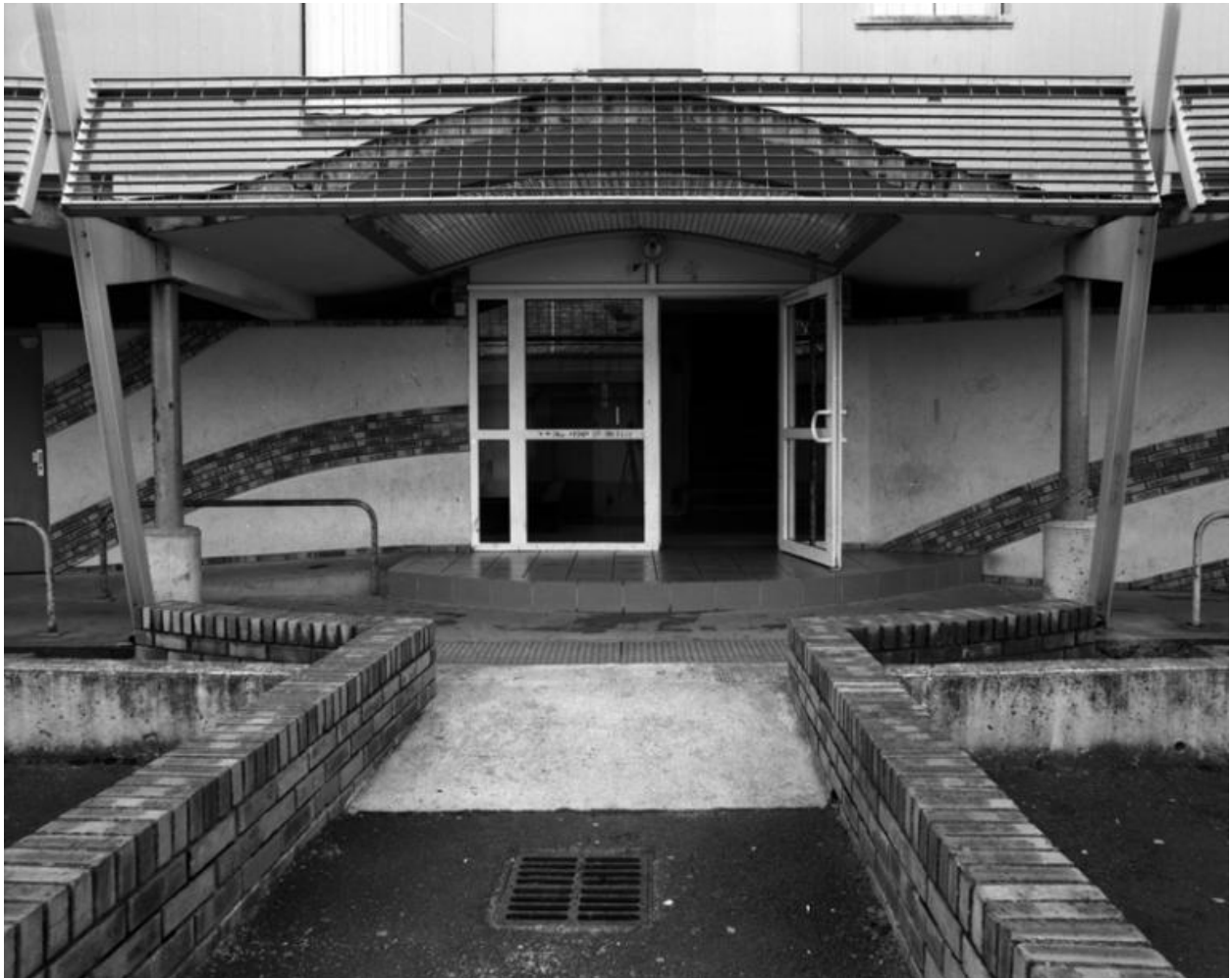
Une des entrées de l'immeuble aujourd'hui détruit, sur l'élévation postérieure nord.
