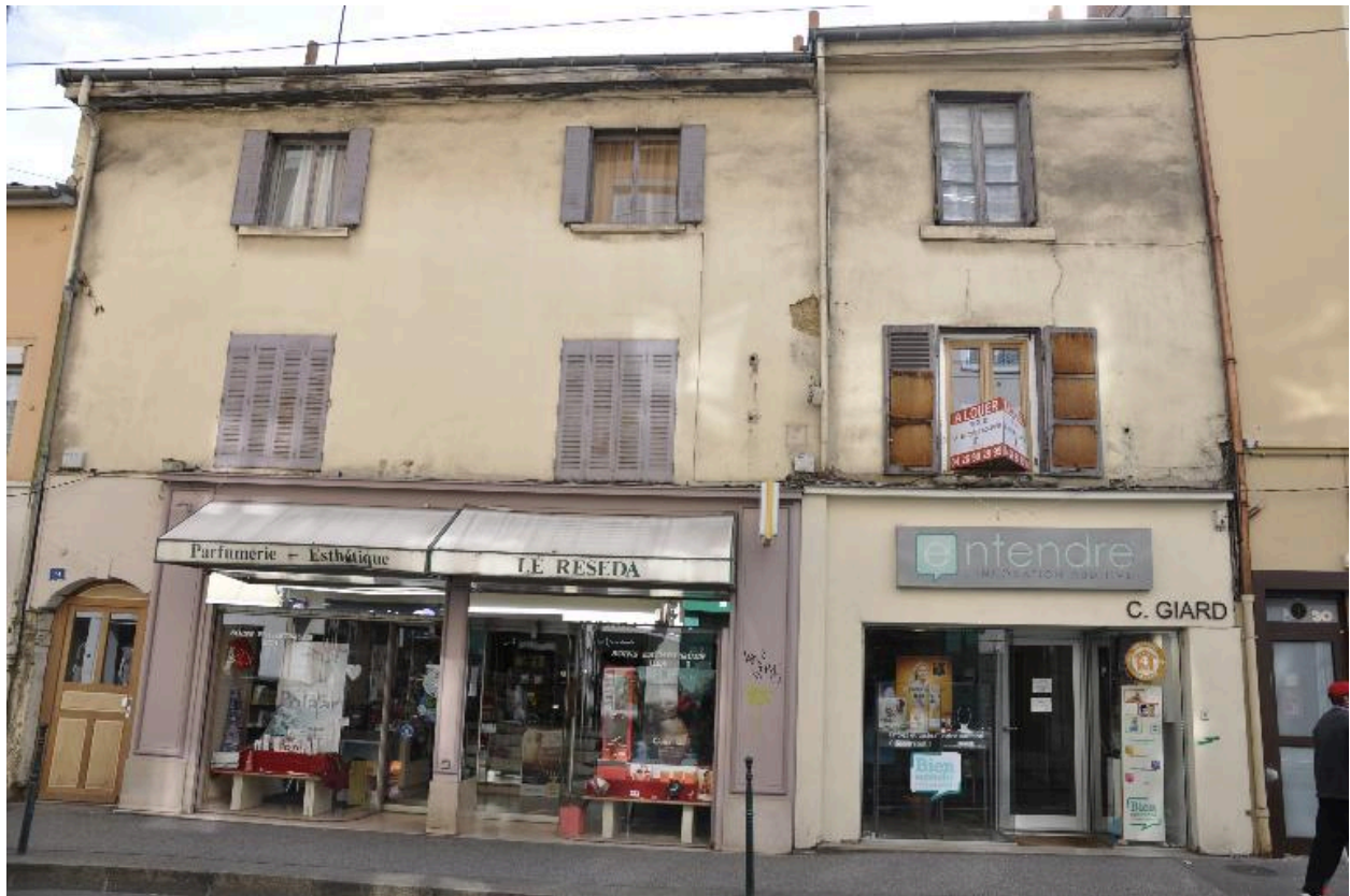
Vue d'ensemble ouest de l'immeuble d'une travée
