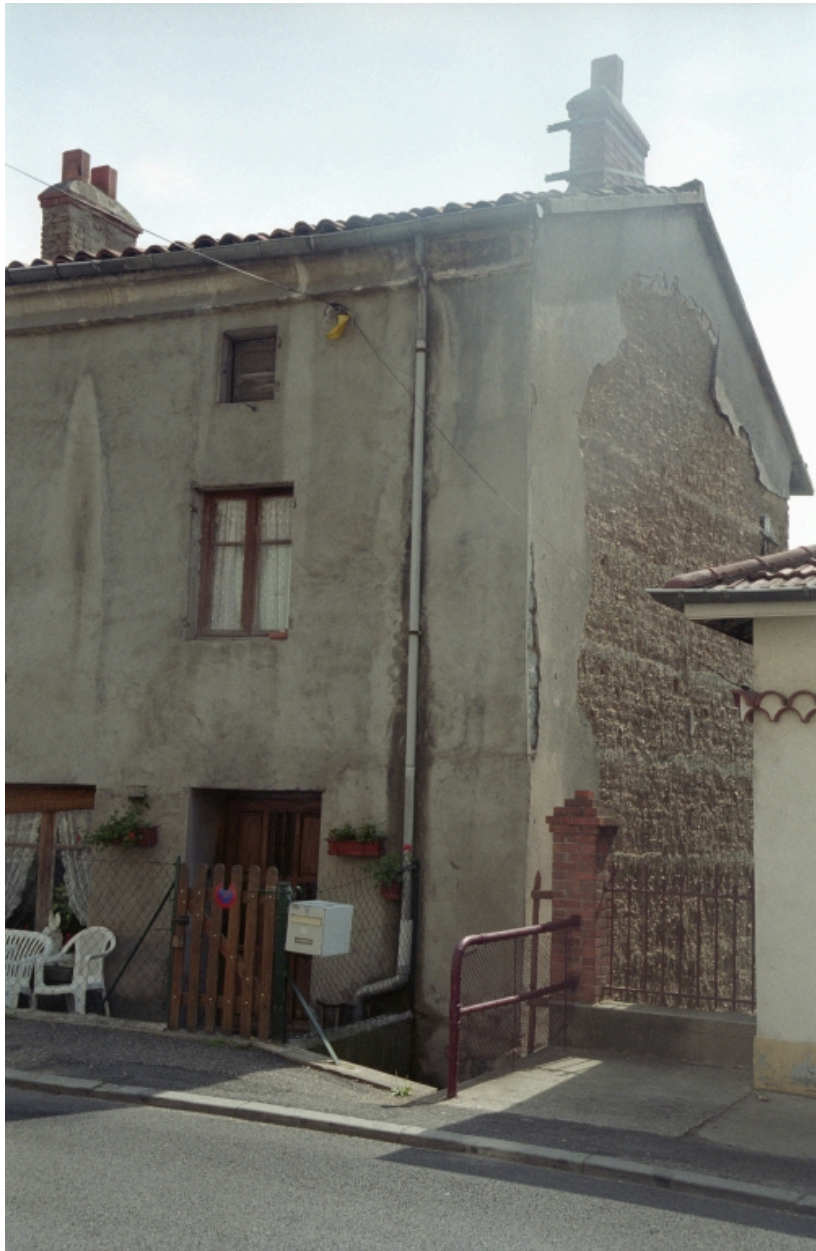
Boën, îlot 18, 8 mai 1945 (rue du) - parcelle AO1. Vue générale de la façade sur rue.
