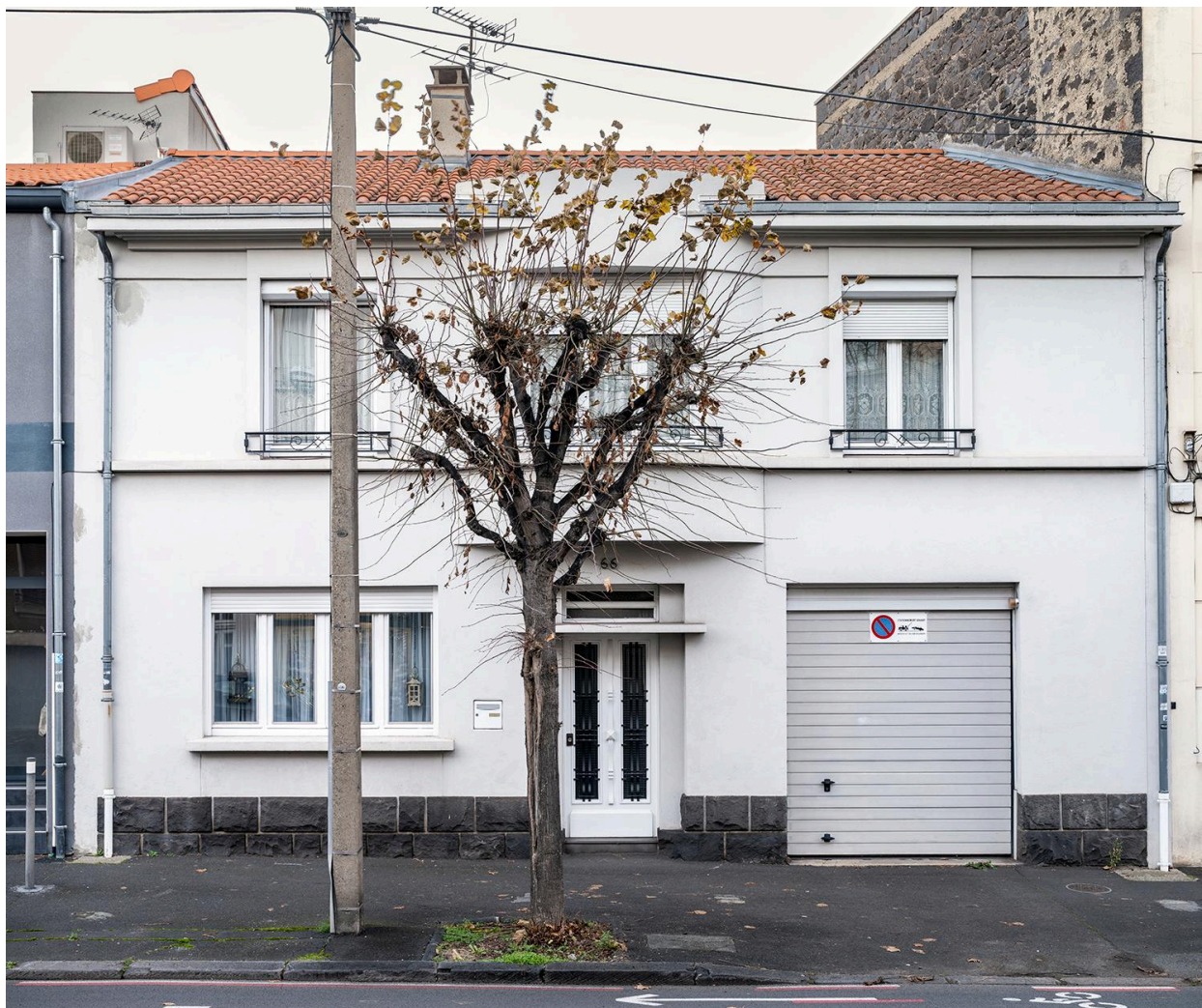
Façade sur le boulevard Jean-Jaurès
