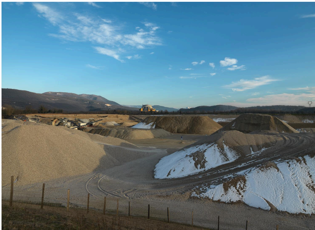
Centrale nucléaire de Creys-Malville
