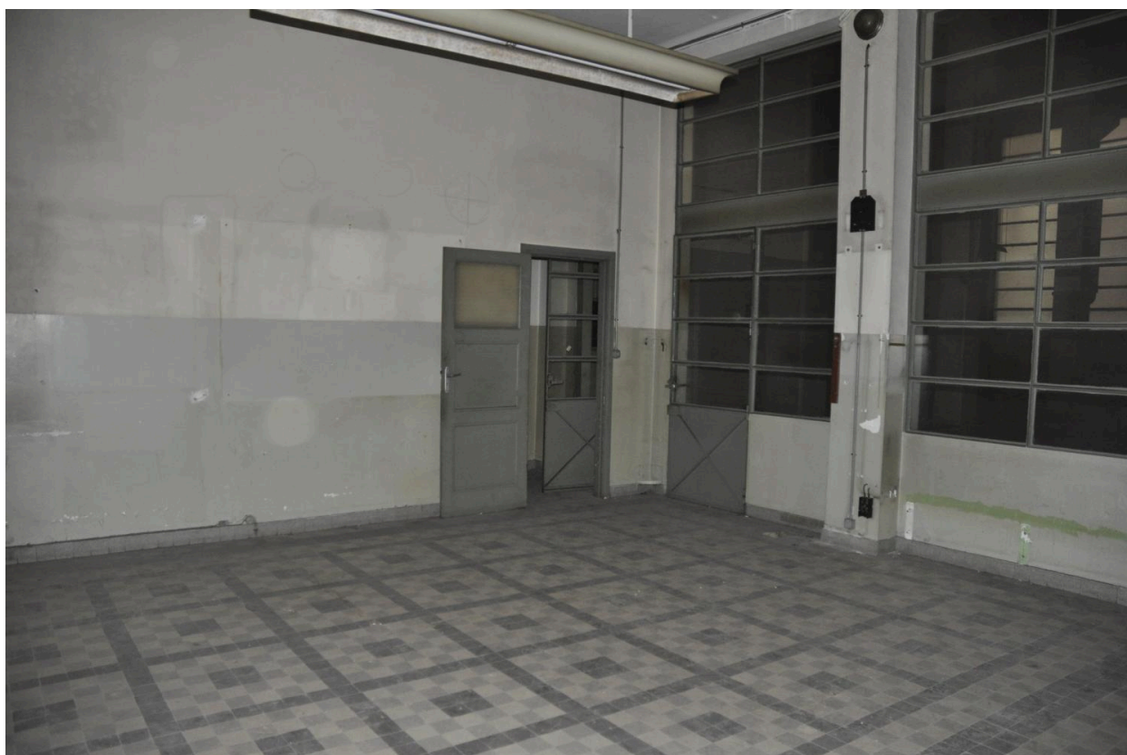
Galerie des transformateurs
