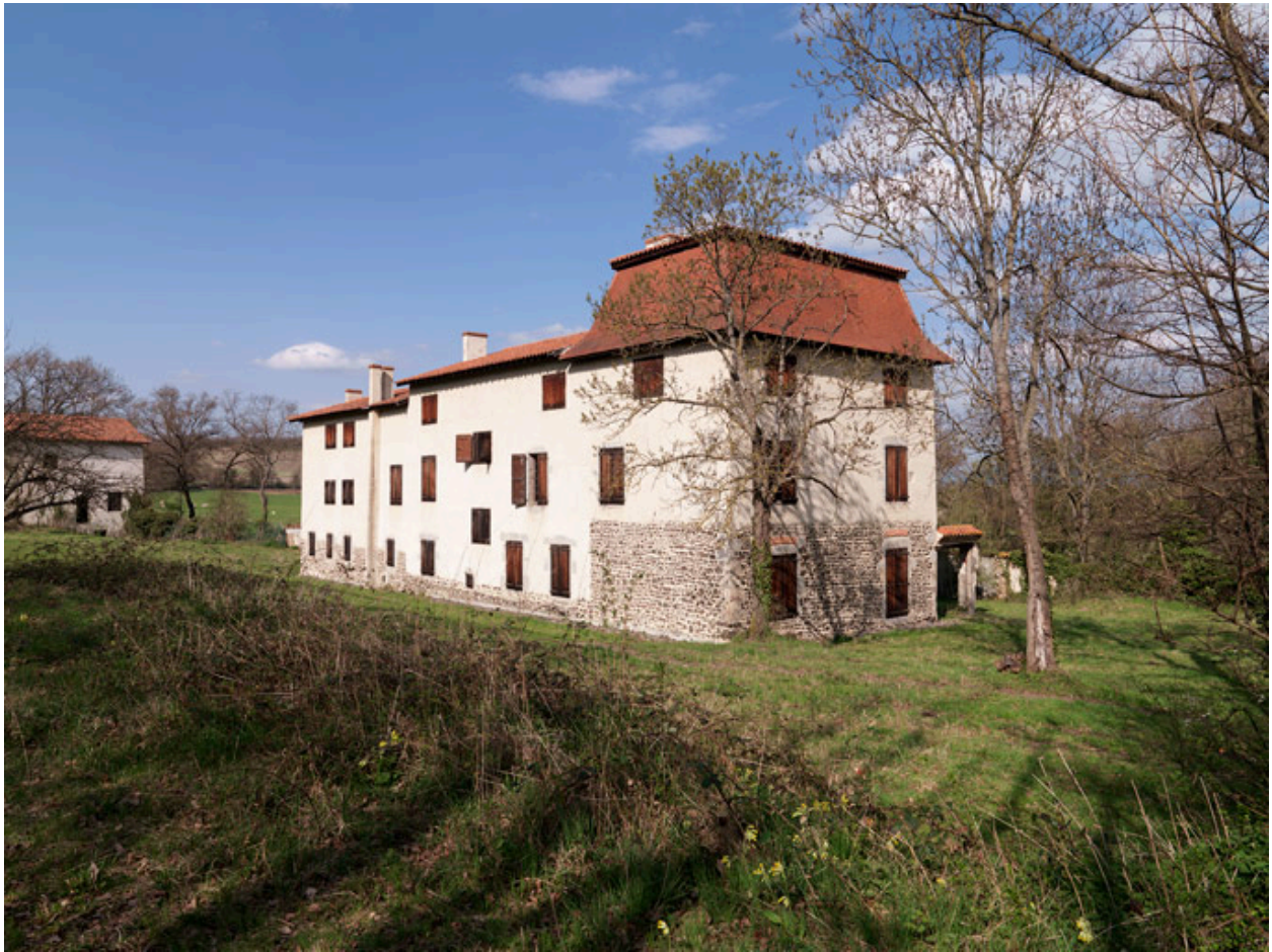
Vue générale depuis le sud-ouest.
