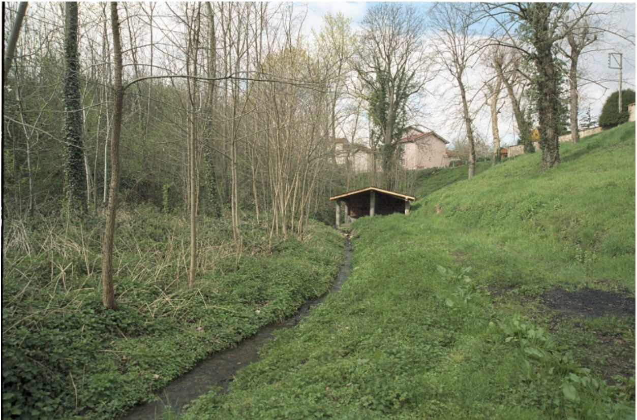
Vue générale du lavoir des Trouillères (1987 A1 64, 65).
