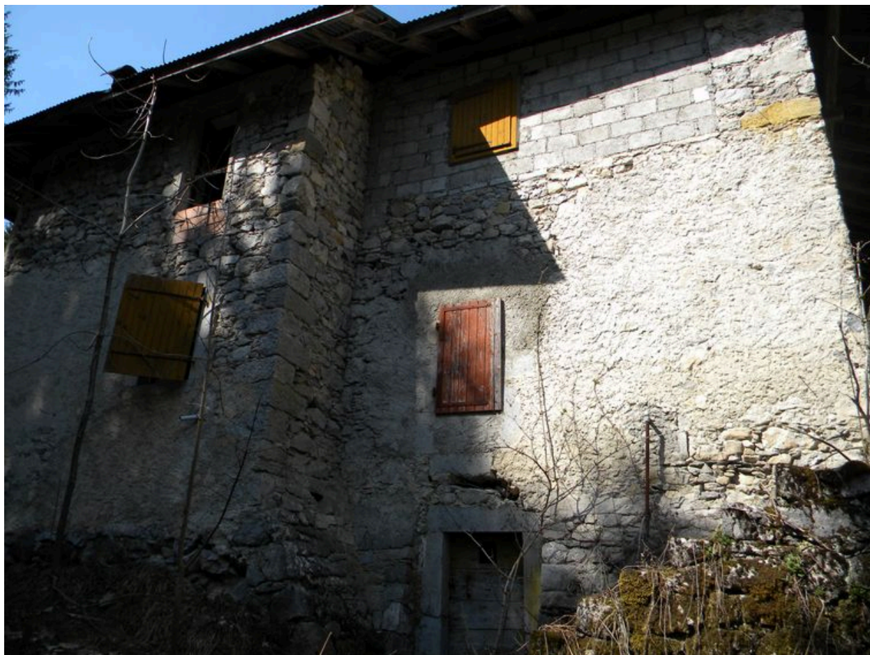
Détail des maçonneries anciennes de la maison forestière.
