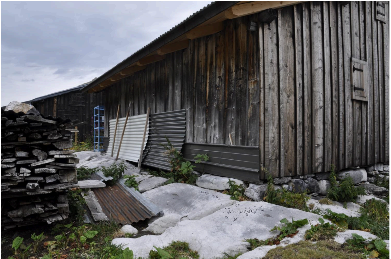
Vue de la façade postérieure ouest
