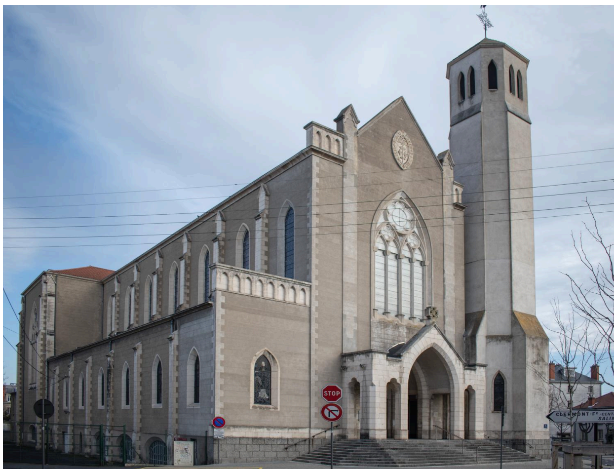
Façade et flanc nord-ouest
