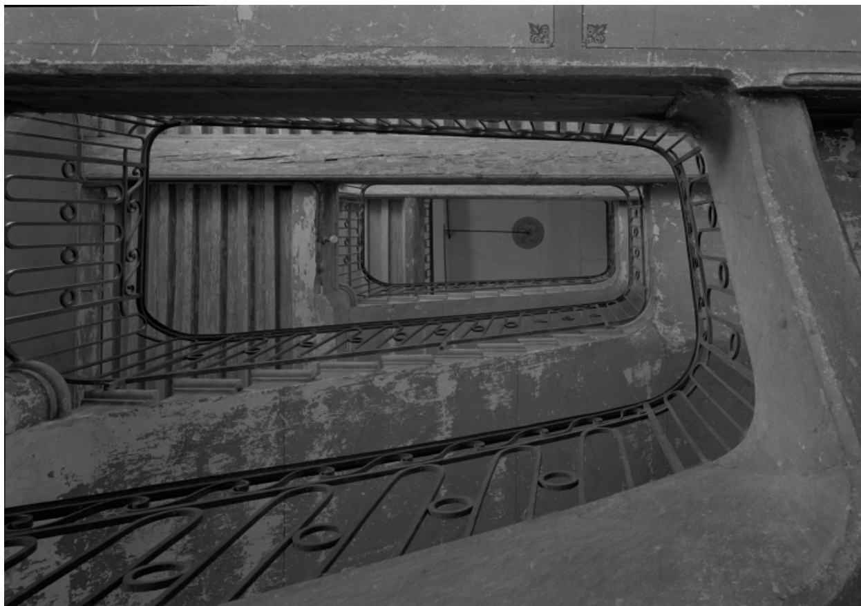
Escalier, vue en contre-plongée.
