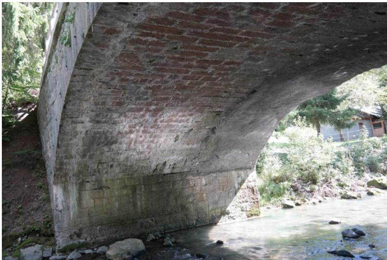
Pont de la Solitude, vue du dessous
