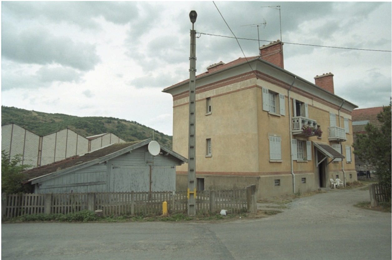
Sail-sous-Couzan, A la Gare, 1986 A 396. Logement des employés de la gare. Vue de trois-quarts.
