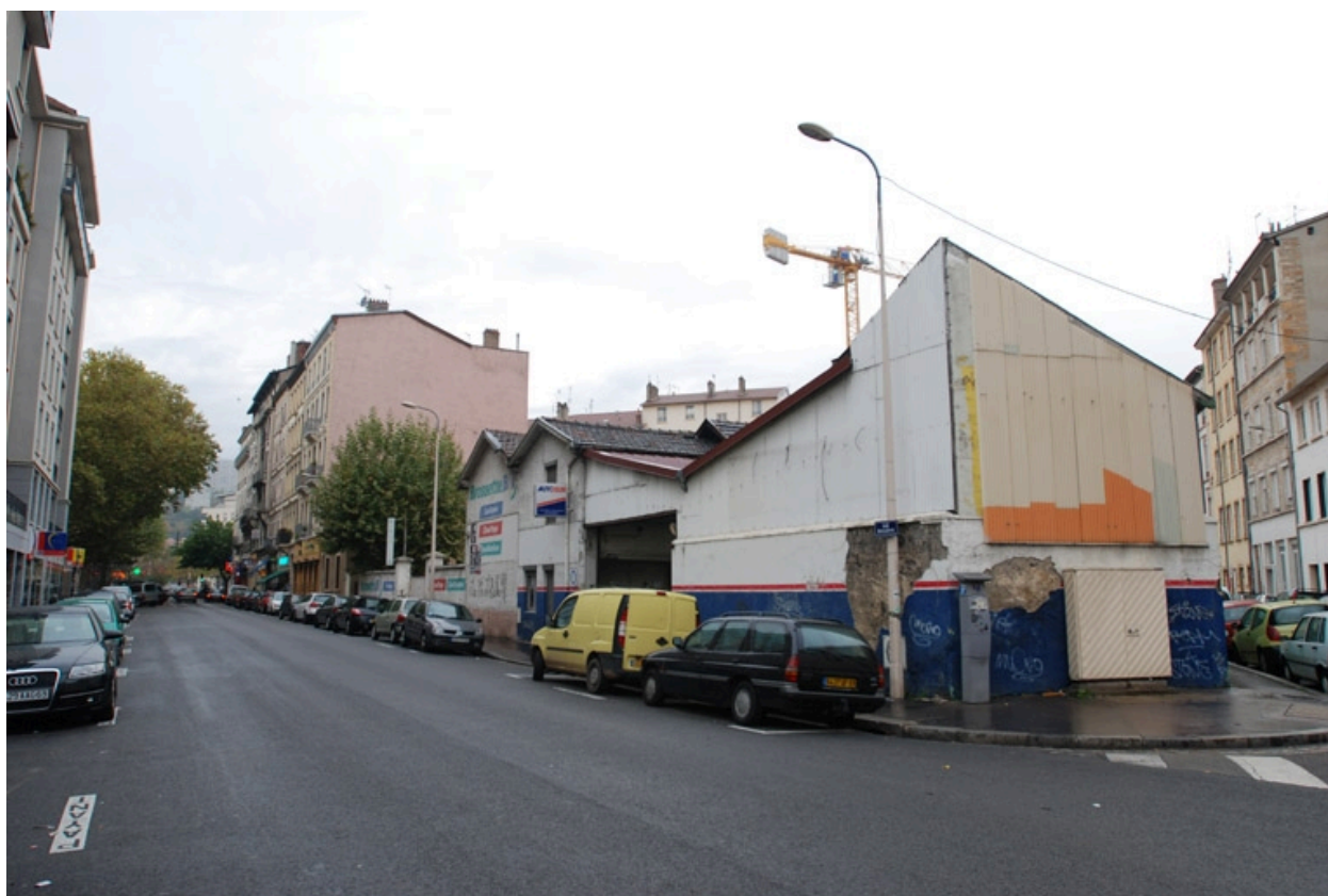
Vue d'ensemble sud du site
