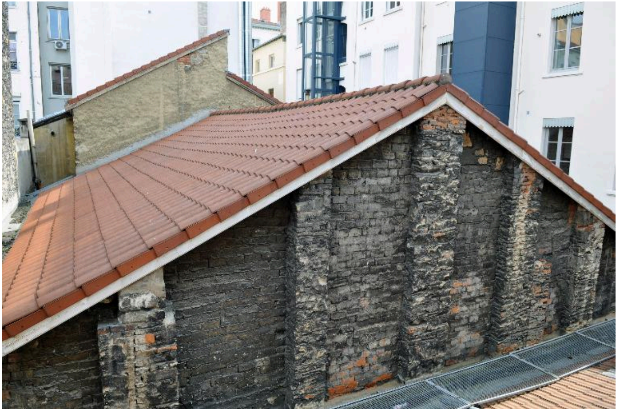
Vue partielle de l'atelier sur cour, mur pignon en briques
