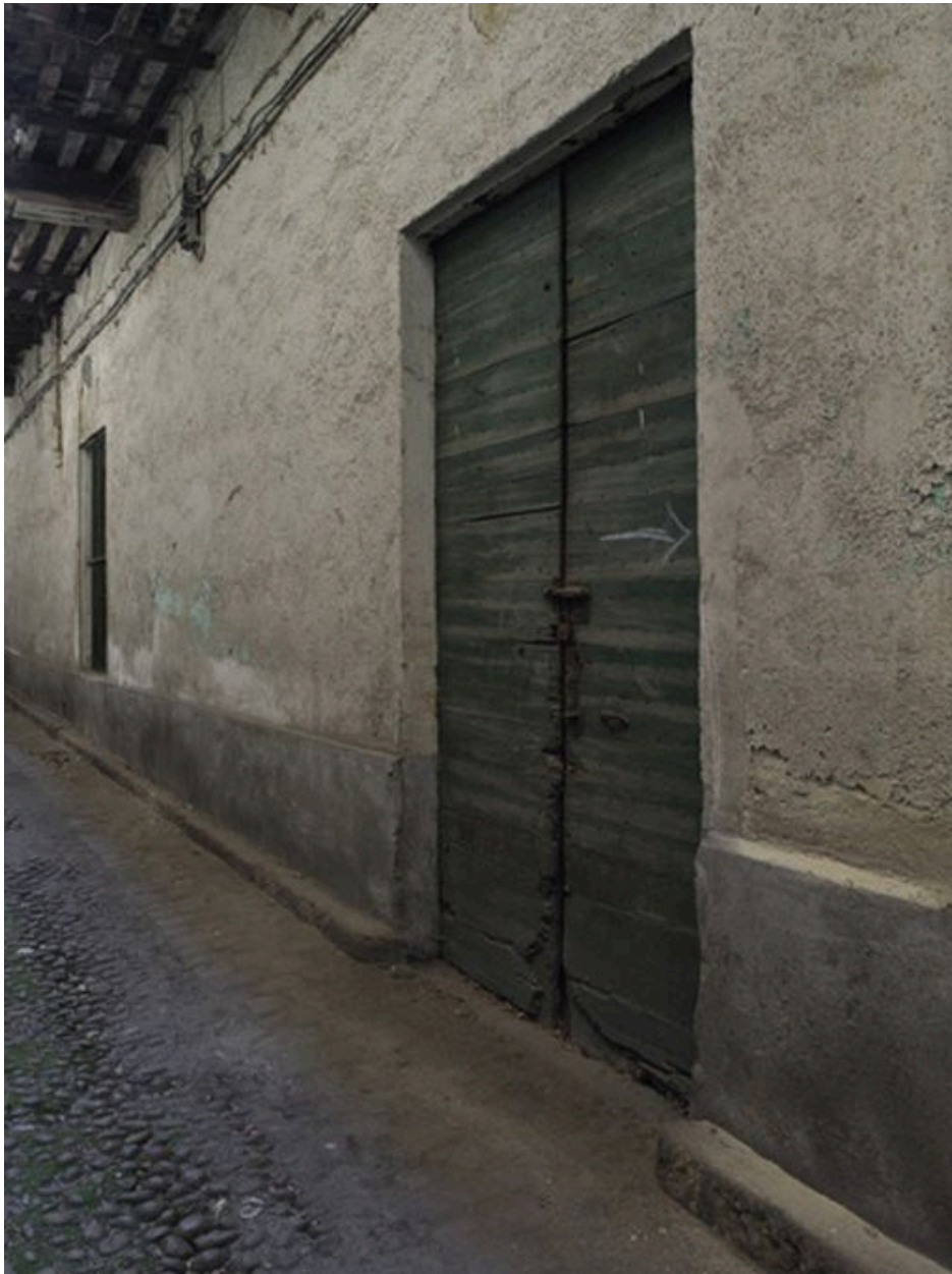
Porte d'un des entrepôts du rez-de-chaussée
