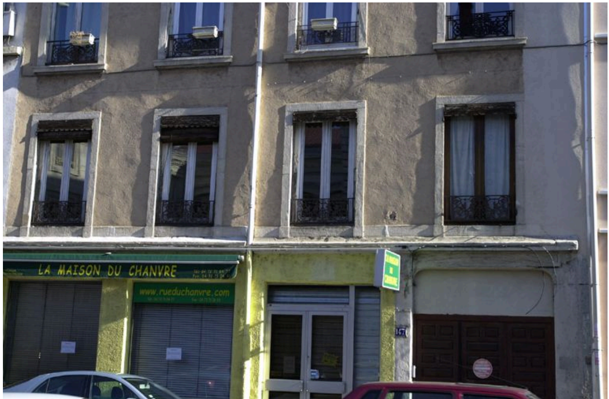
Elévation antérieure, détail du 1er étage
