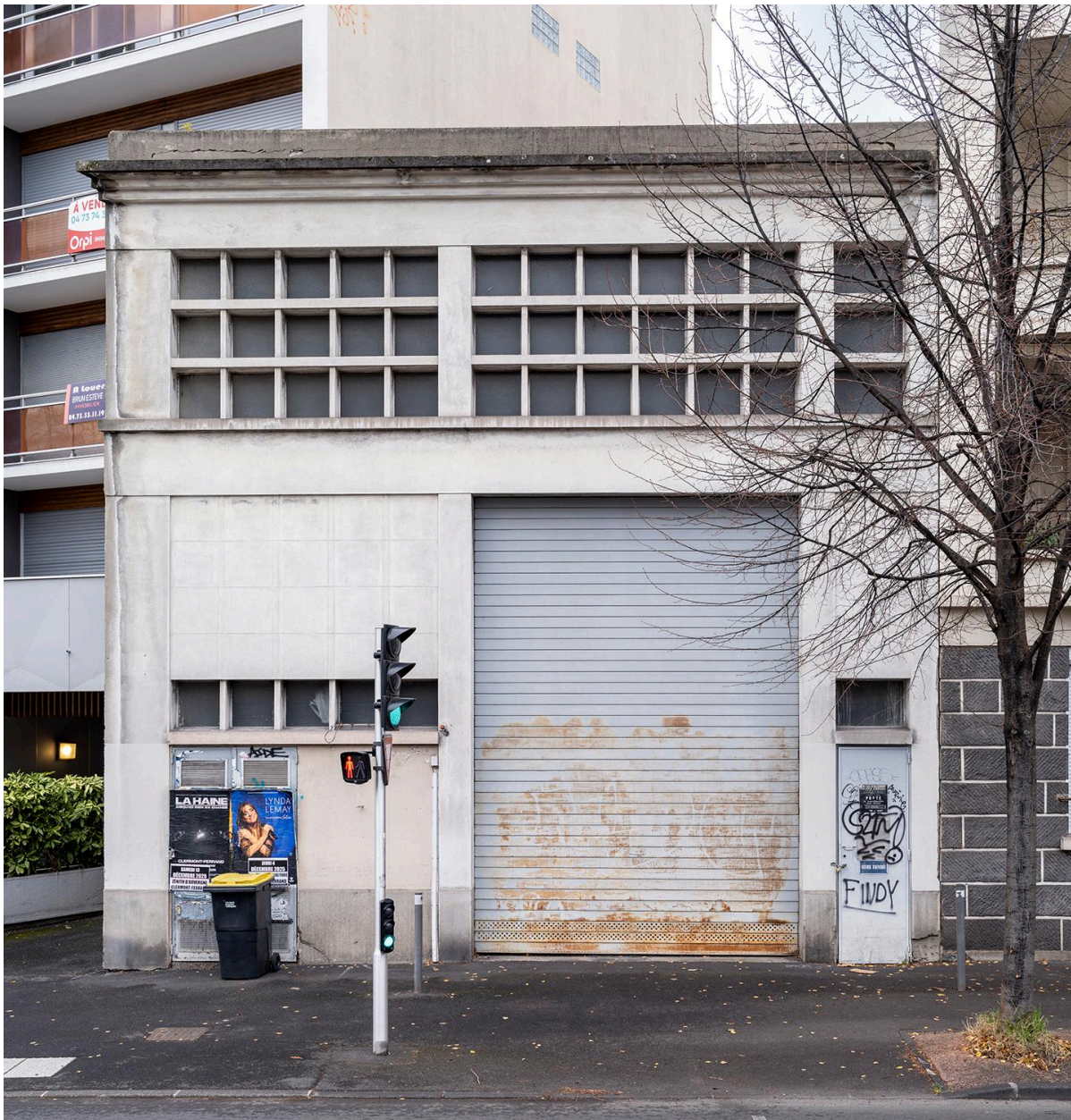
Façade sur le boulevard Aristide-Briand
