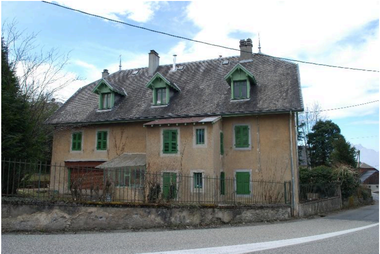
Maison-villa (Trévignin, 2014 B4 947), vue sur cour (face nord-est).
