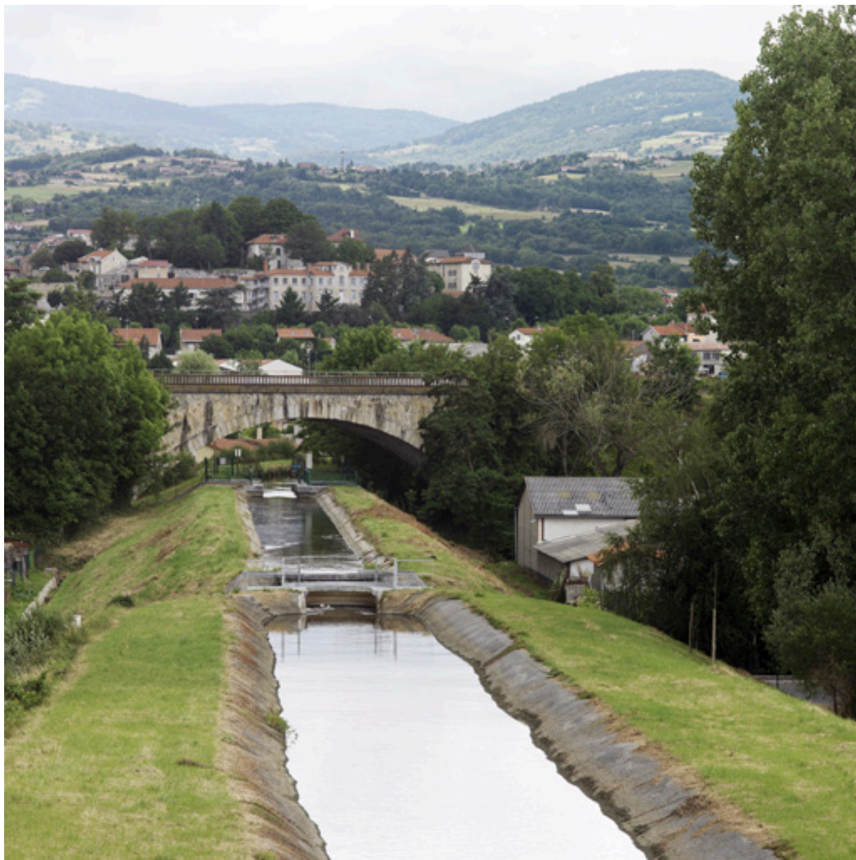
Vue du canal (partie sur la commune de Savigneux), avec le pont de chemin de fer puis Montbrison en arrière-plan.
