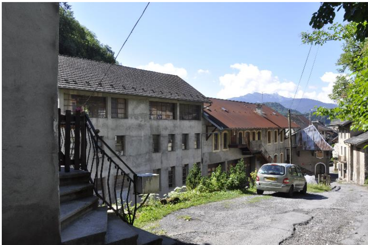
Vue de la cour intérieure prise depuis la voie communale du Vieux Pont
