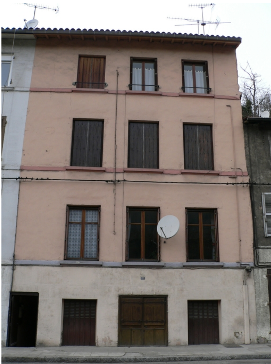
Vue générale de la façade
