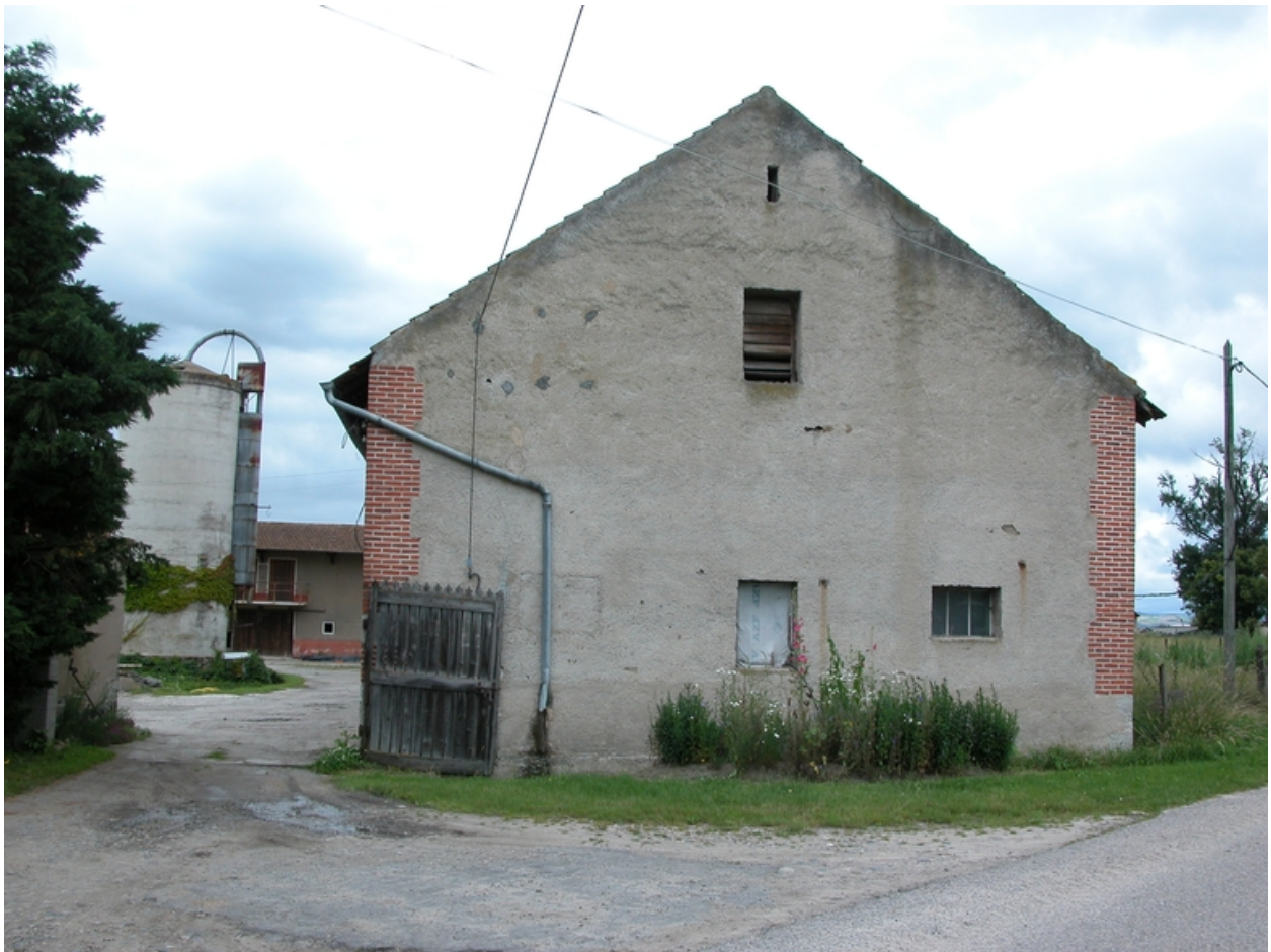
Mur pignon de l'écurie à l'extrémité du bâtiment nord.
