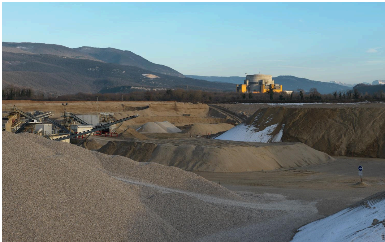
Centrale nucléaire de Creys-Malville
