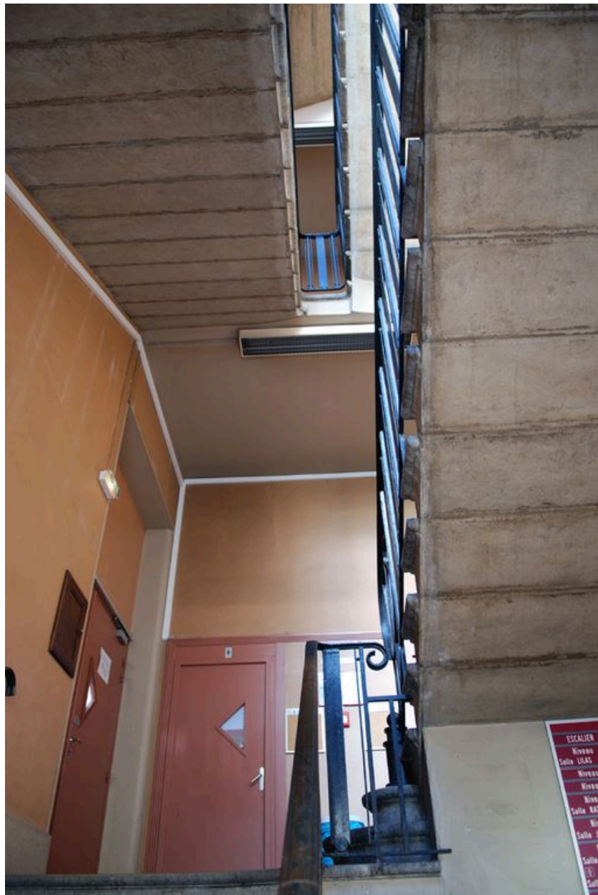
Bâtiment Leperc, escalier, palier du 1er étage.
