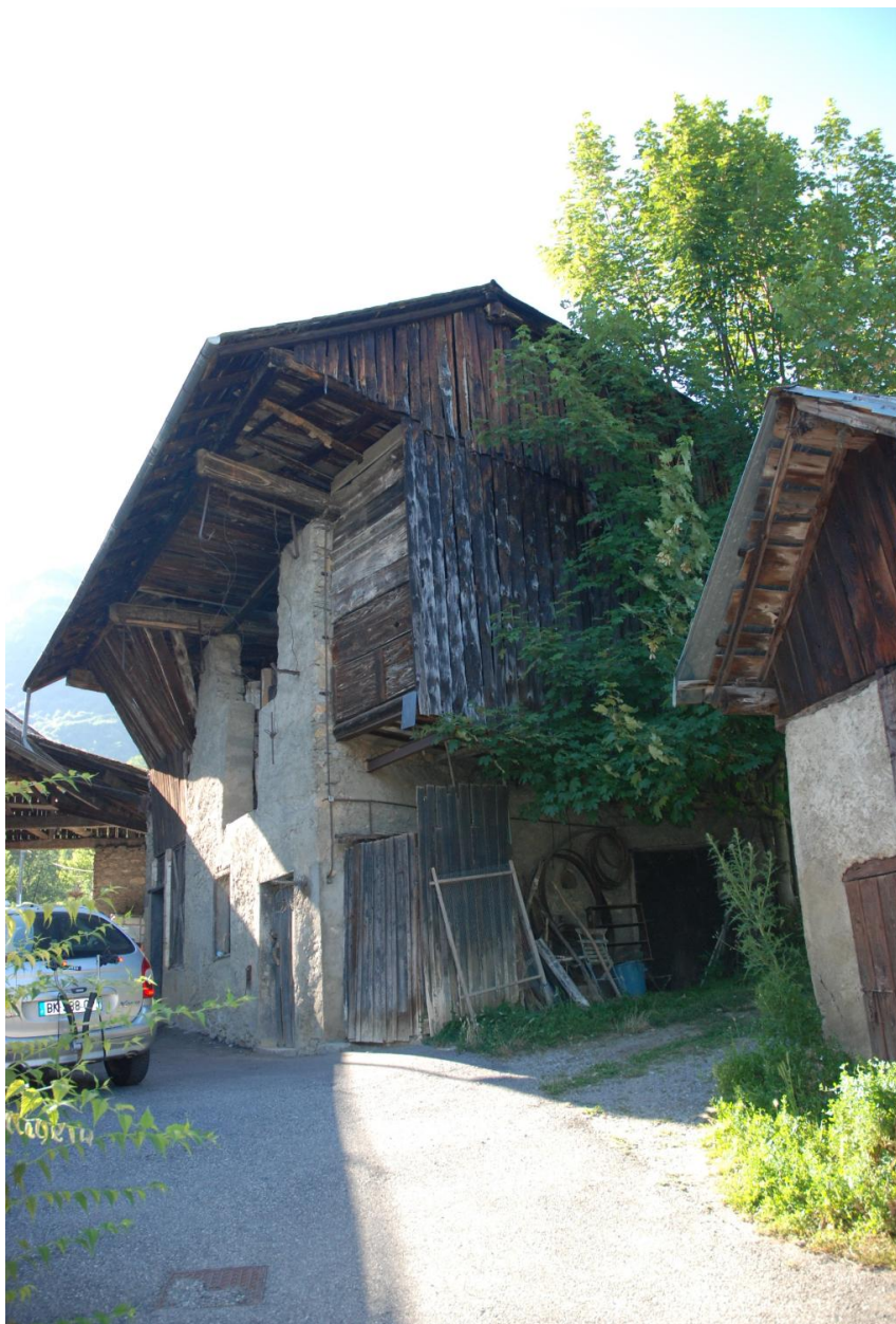
Fermes à bâtiments disjoints (2018 I1 57, 58, 1261), vue de la grange-étable, cuvage, atelier (58).
