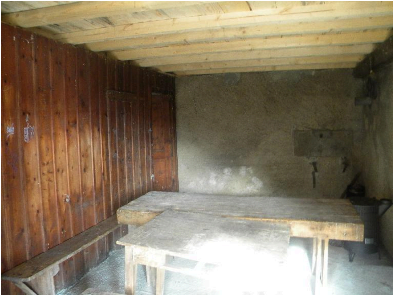
Vue de la salle principale du bâtiment sud.
