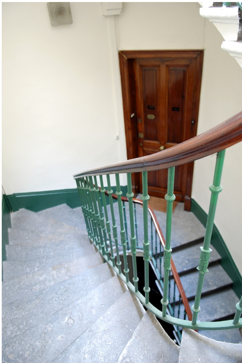
Escalier et porte palière
