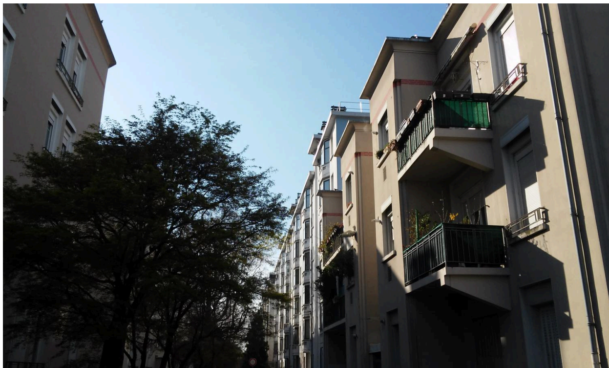
Balcons immeuble prototype
