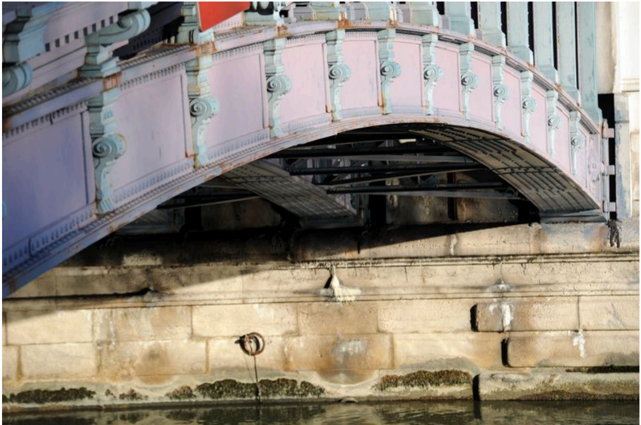
Arche, face aval, de dessous, vue de détail : ancrage à la pile (depuis la rive droite)
