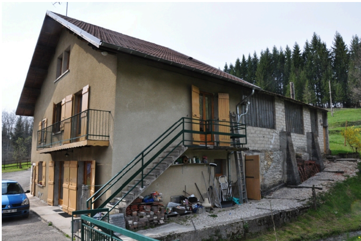
Vue générale du moulin à huile, façade est
