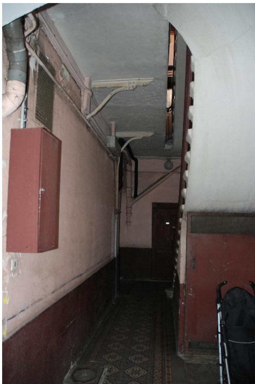
Vue de l'allée depuis l'accès à la cour
