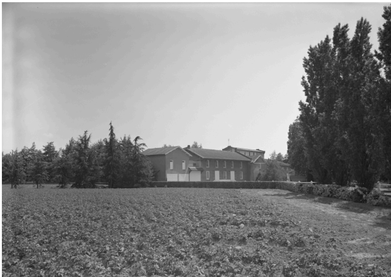
Vue de situation, prise depuis la route (nord-ouest).
