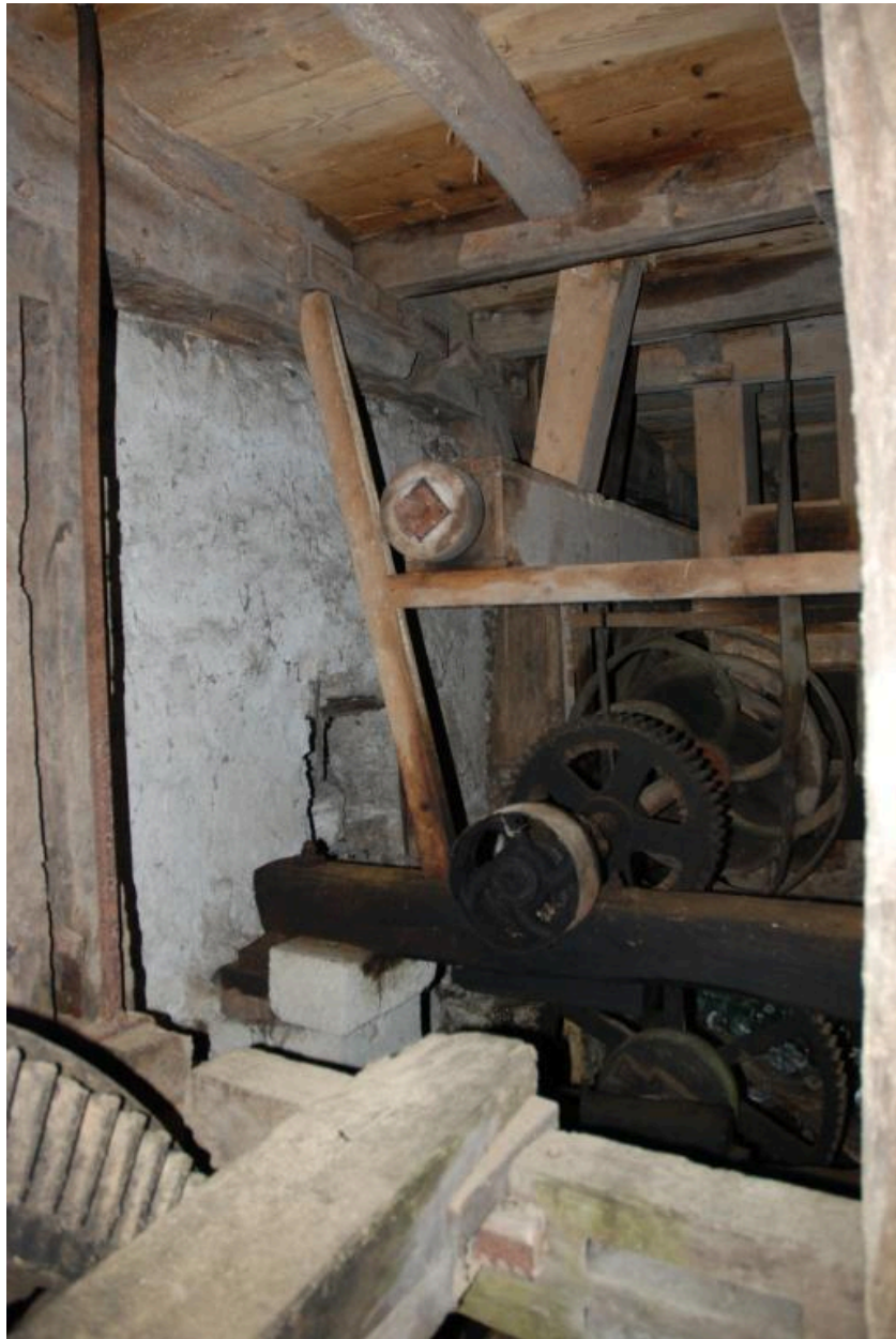
Vue intérieure de l'étage de soubassement, partie nord : arbre de transmission et engrenages contre le mur de refend.
