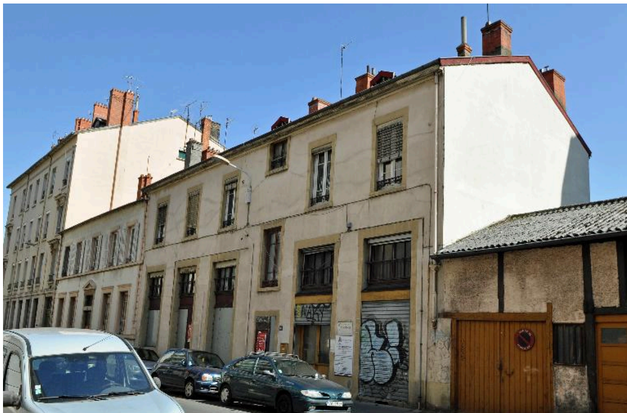
Vue générale de l'immeuble, élévation sur rue
