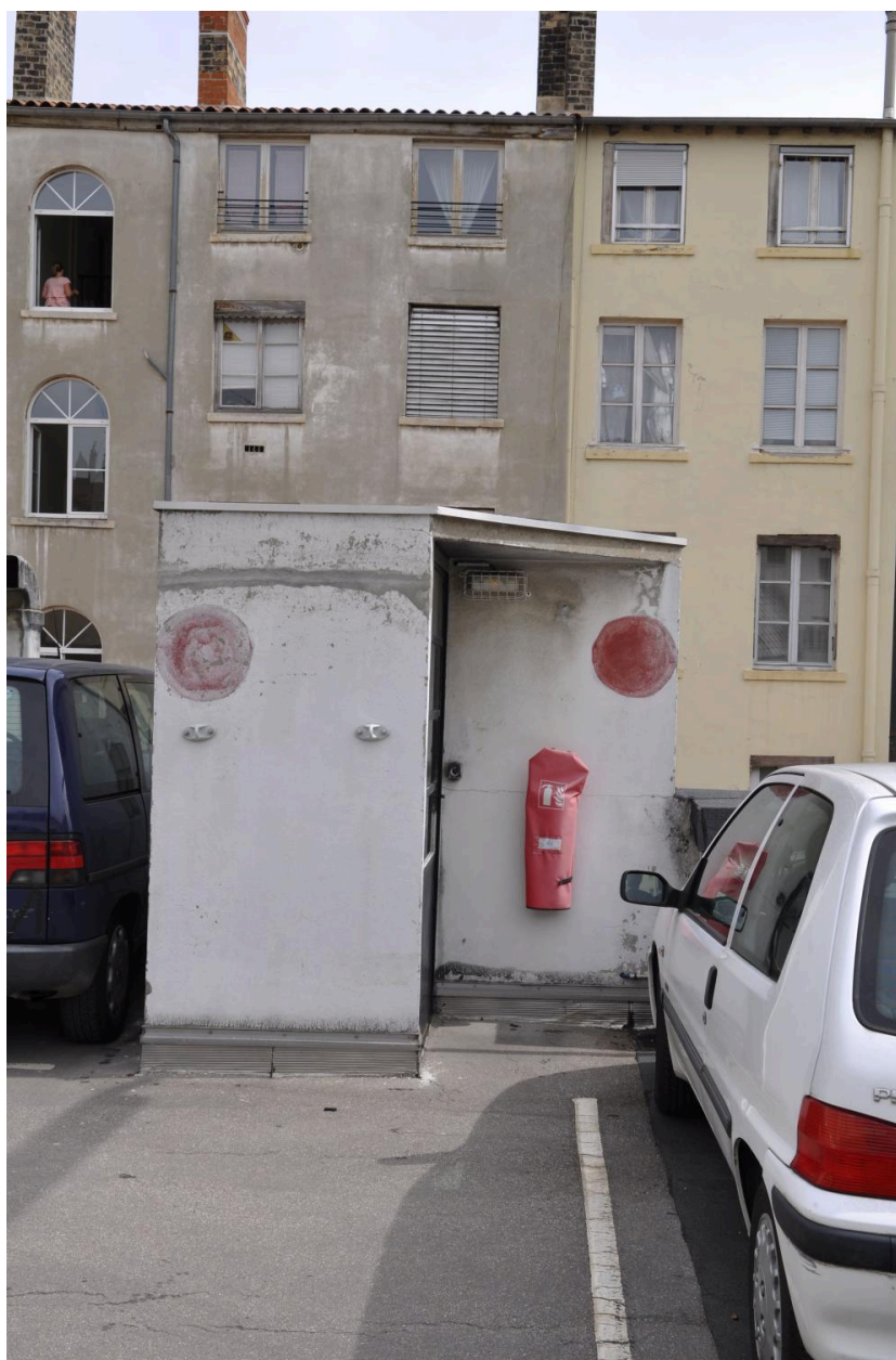
Détail de la porte d'accès au parking, vue extérieure
