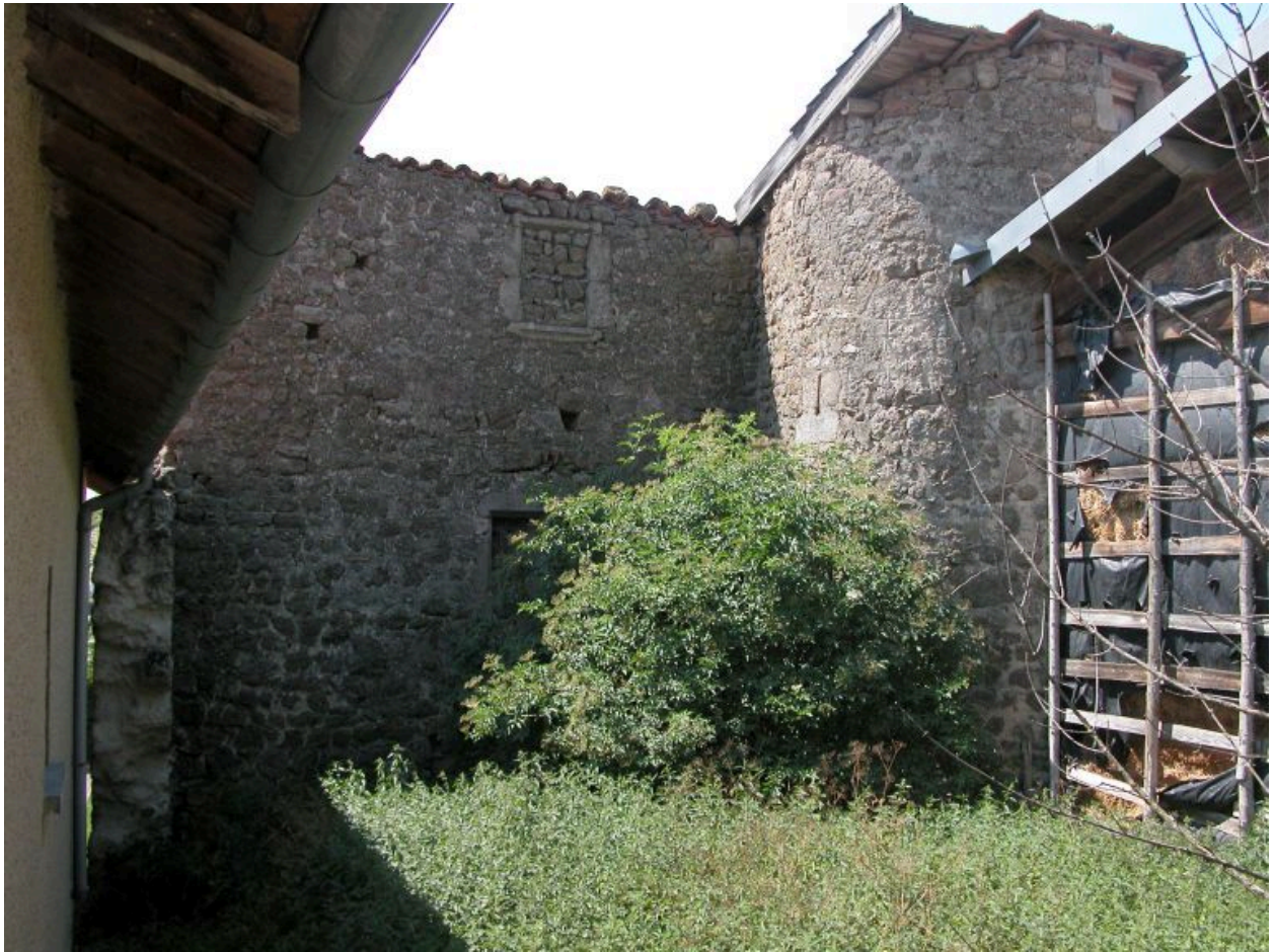
Vue d'ensemble partielle de la façade arrière de l'aile nord du château.
