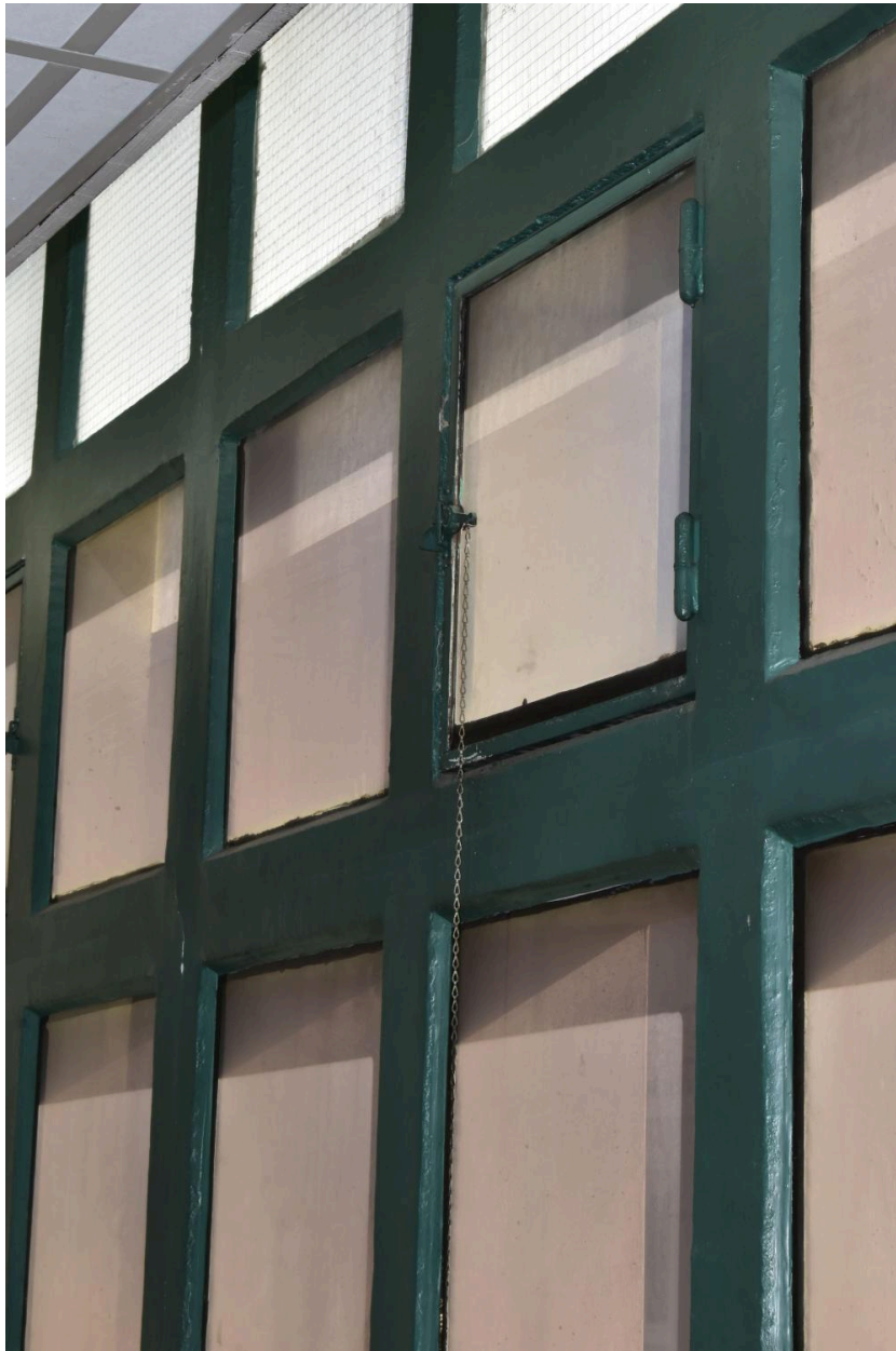
Détail du système d'ouverture d'une des claustras éclairant le parloir.
